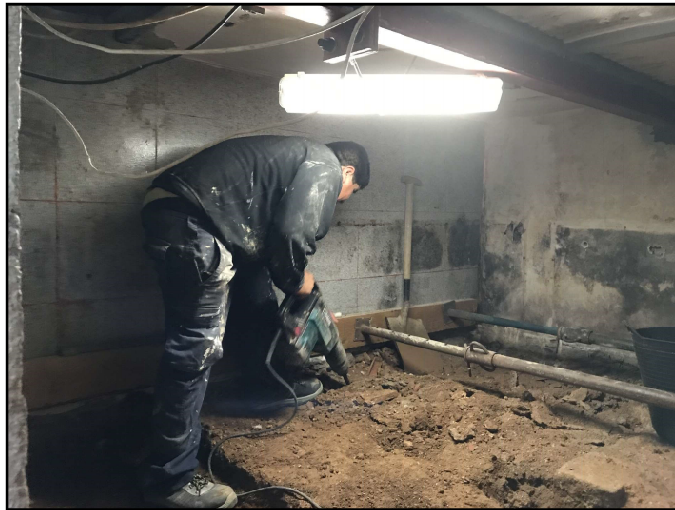
Treballs d'excavació dels nivells superiors de la zona B
